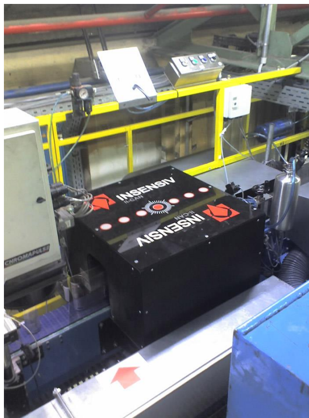
Bild 3: insensiv-Inspektionseinheit im Einsatz
